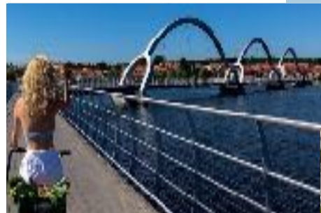
Sölversborg, Gång- och cykelbro.
