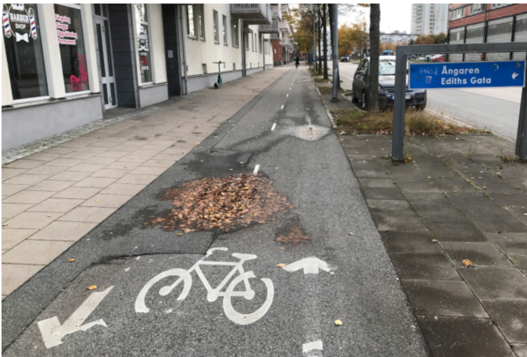
Sannegårdsgatan: Den smala pendlingscykelbanan går tätt intill portar och gångremsa. Samtidigt finns bilparkeringar som knappt används.
