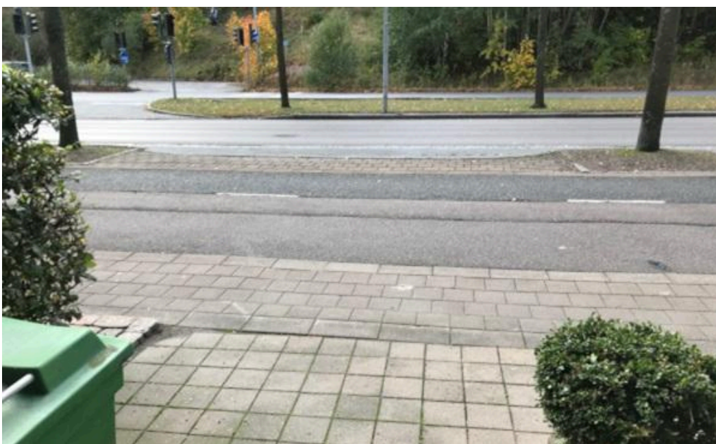
Husport ut mot Östra Eriksbergsvägen. Skygglappsutformning och diverse skarvar i ytan. Är det tydligt hur mycket av detta som är pendlingscykelbana?
