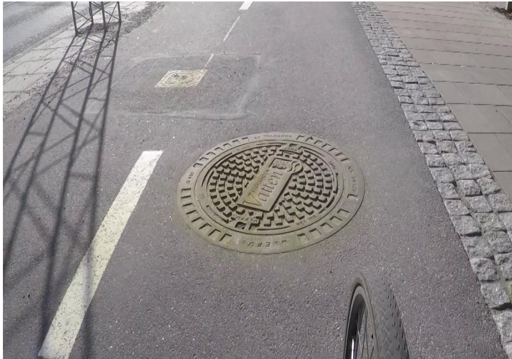
Brunnslock utan kant
