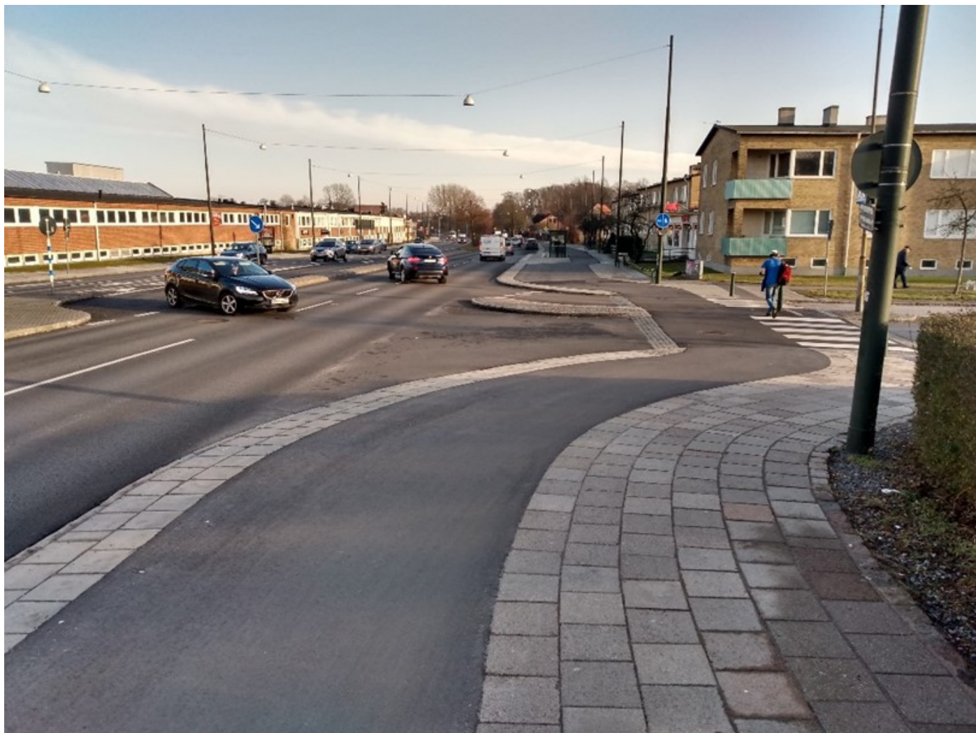
Tvåra svängar i cykelbanan medan bilvägen fortsätter rakt fram.
