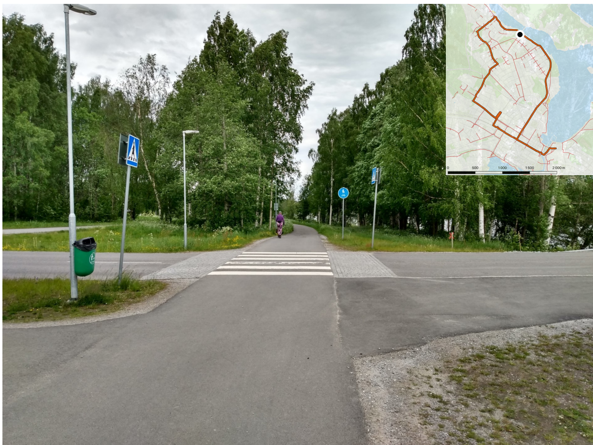
Foto 7. Det är förvisso tillåtet att cykla på ett övergångsställe, men det är långt ifrån optimalt att leda en huvudcykelled över ett övergångsställe. Motorfordon behöver enbart lämna företräde om cykeln leds .
