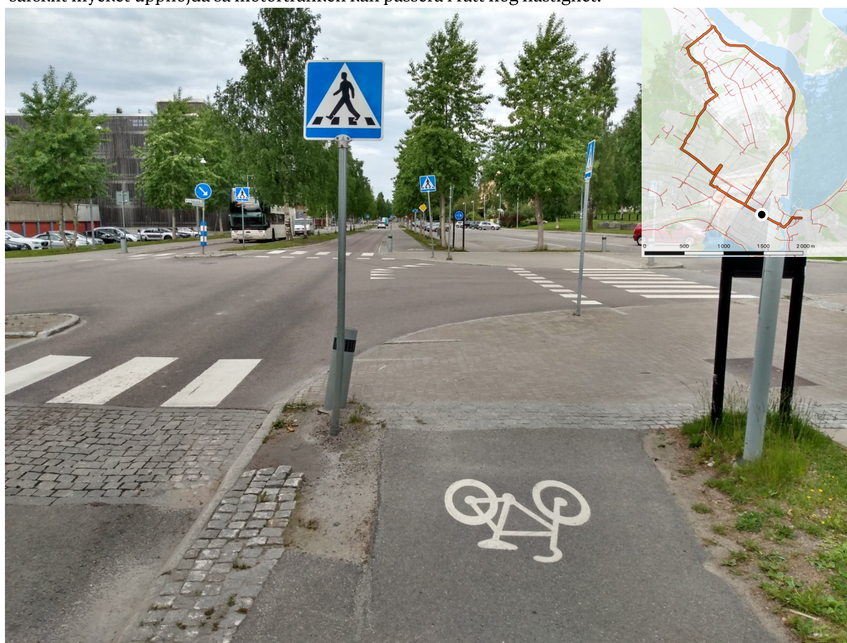
Foto 6. Två svängar åt höger och vänster samt rader med gatstenar som försämrar framkomligheten och komforten i korsningarna längs Sundsgatan. Jämfört med motortrafiken som får köra spikrakt genom korsningarna är detta ett sätt att försämma konkurrenskraften för cykel i tätorten. Cykelbanan är smal för att vara dubbelriktad och det finns en risk att fasta med styret i stolpen vid början av cykelpassagen.
