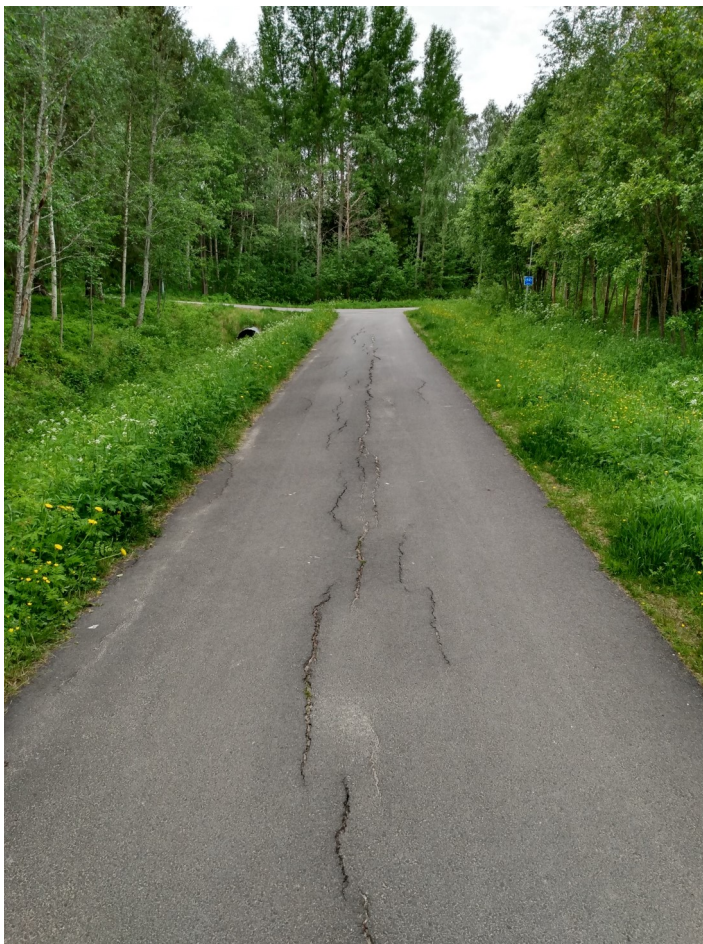
Foto 3. Långa sprickor i asfalten går att finna på flera platser längs stråket. Det är också smalt och saknas separering mot gående.
