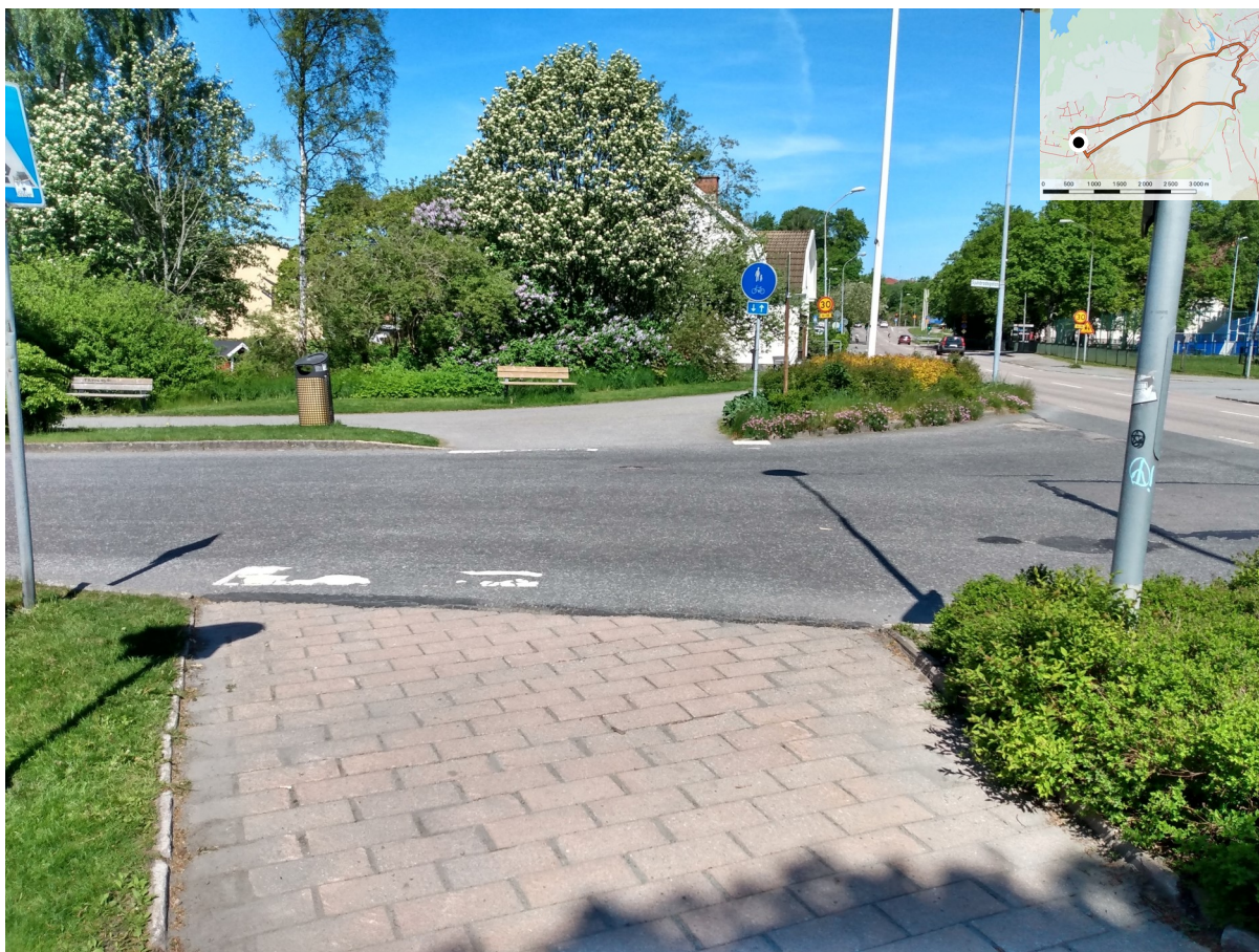
Foto 3. Vid korsningen Örbyvägen—Sjuhäradsgatan finns en skylt för övergångsställe men markeringen i gatan är borta. I och med beläggningen av betongplattor uppfattas det snarare som en gångbana.
