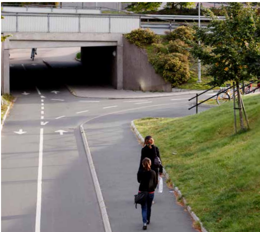
Exempel på väl separerad tunnel i Jönköping
