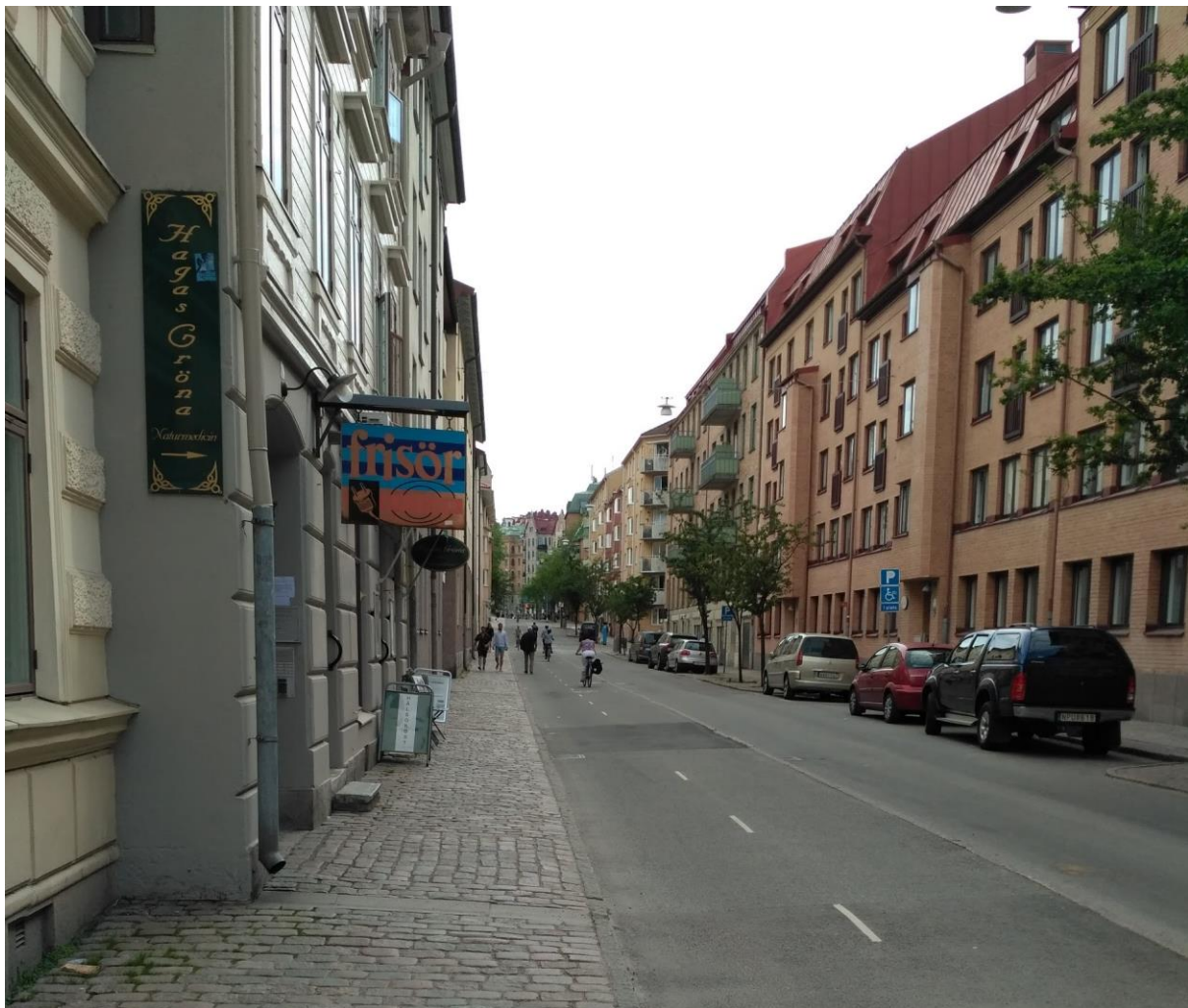
Figur 8. Olämplig utformning av gångbanan vid Landsvägsgatan.
