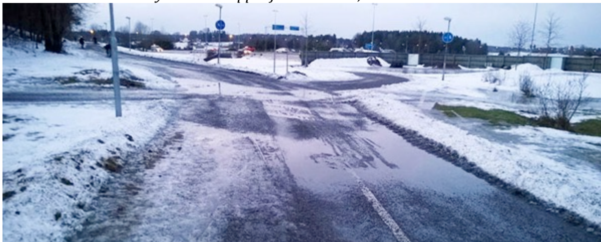
Inrinning vintern 2014/15. Cykelbanan är inte upphöjd eller välvd i mitten utan lutar från vänster till höger. Därmed rinner smältvatten ut på GC-banan och fryser till is när temperaturen sjunker igen. Cyklisten blir nedstänkt.
