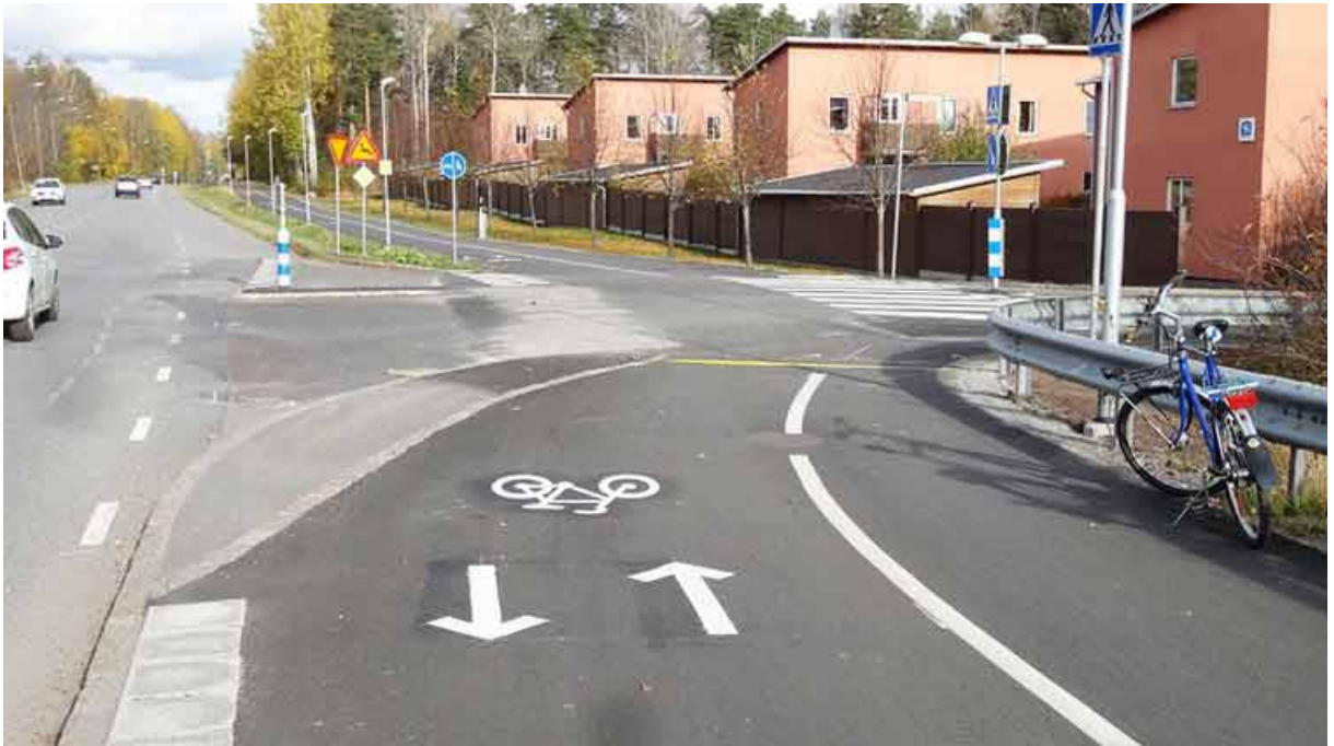
Bild 4. Korsningen vid Malmavägen. Vi kommer till en kritisk plats – en korsning – och plötsligt trängs GC-banan ihop till en totalbredd av 2,8 meter. Avbärarräcket borde ha flyttats.
