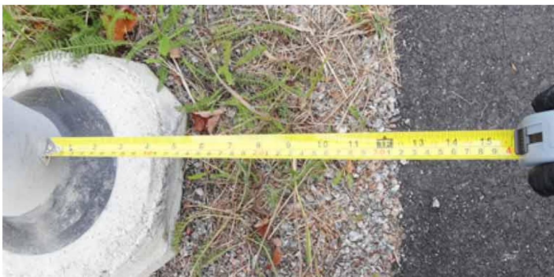
Bild 12 Flera stolpar längs Vårdsätravägen står närmre än 0,6 meter från cykelbanan.
