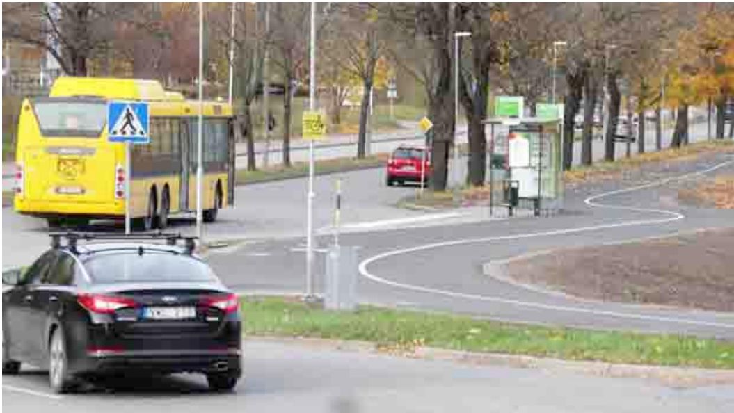
Bild 1 Gott om utrymme, men ingen skiljeremsa eller räcke mot hållplatsen. GC-banan går alldeles intill fast hinder (kuren) och gör en tvär sväng med dålig sikt.
